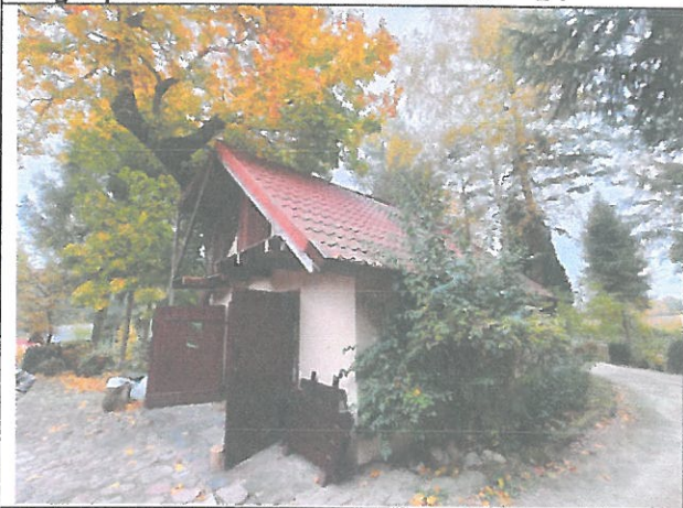
Budynek gospodarczy – widok 1
