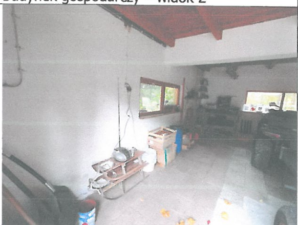
Budynek gospodarczy – widok 4
