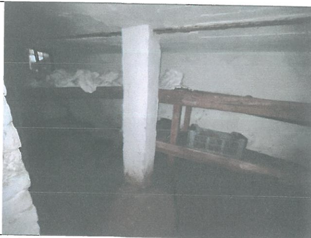
Zabudowa gosp. (piwnica) – widok 2
