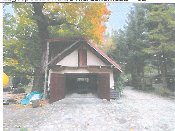
Budynek gospodarczy – widok 2
