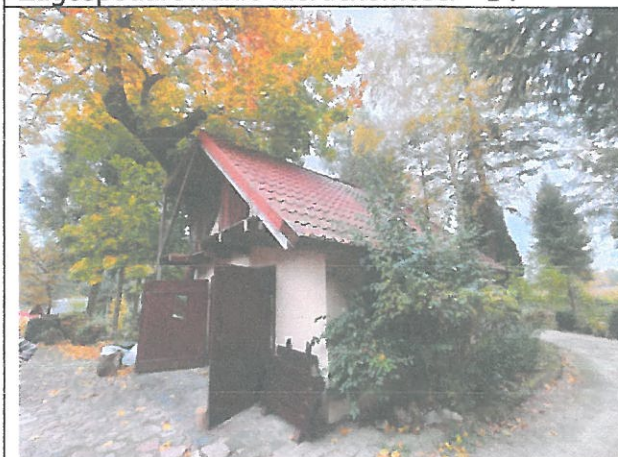
Budynek gospodarczy – widok 1
