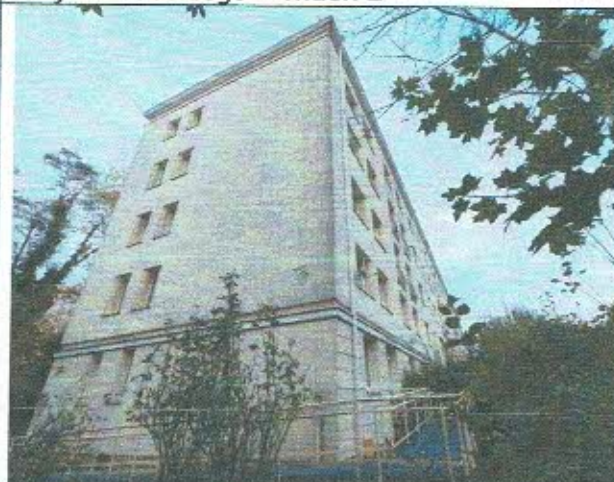
Budynek z zewnątrz – widok 2
