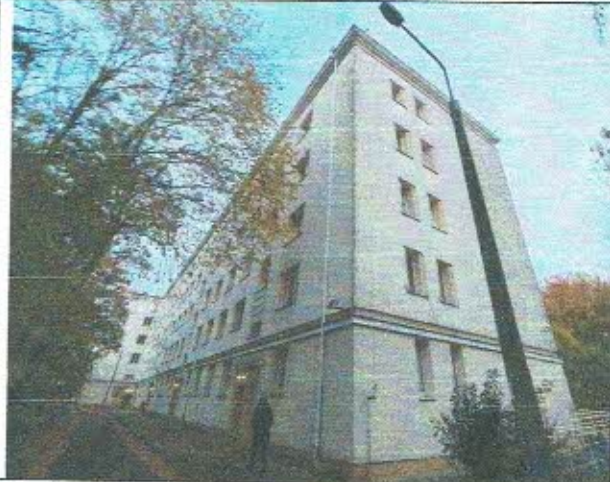
Budynek z zewnątrz – widok 1
